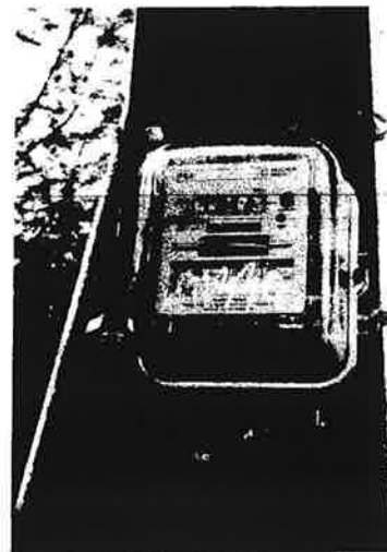
รูปที่ 3 สายไฟฟ้า Main จากการไฟฟ้าภูมิภาคก่อนเข้ามิเตอร์ตรวจวัดถูกตัดขาด
